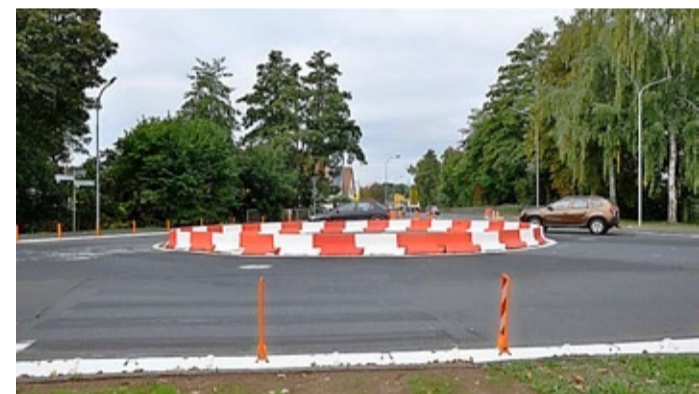
Funktion erfüllt: Der Verkehr rollt reibungslos über den neuen und noch provisorischen Kreisell.
