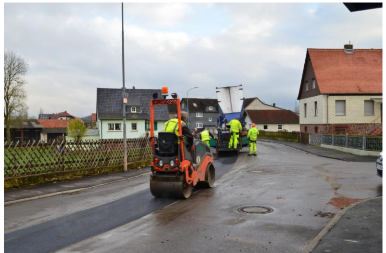
Die Bauarbeiten zum Nahwärmenetz Kleinseelheim schreiten voran. Im Sandweg wird der nach Verlegung von Nahwärme- und Glasfaserleitungen geschlossene Graben asphaltiert. (Foto: Waldhardt, 29.11.2017)
