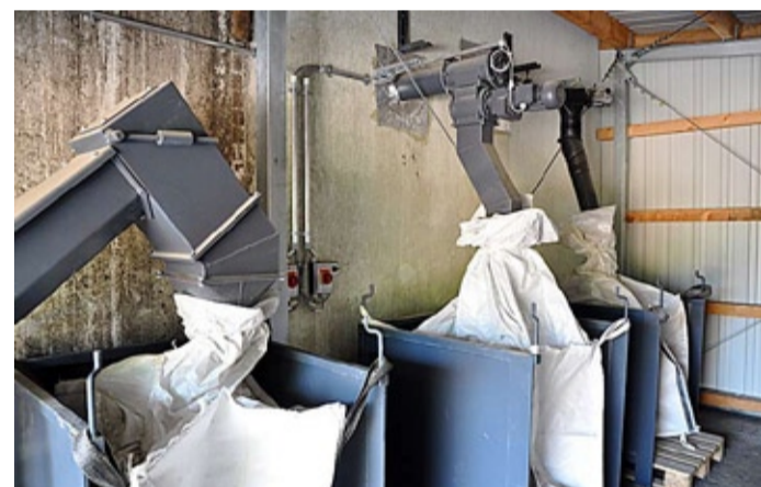
Nur die Rostasche (links) landet ungefiltert im Sack. Die Zyklon- und die Filterasche müssen durch Spezialfilter.
