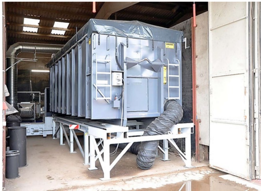
Containerweise wird das Schnittgut von der EAM angeliefert, das nach einem Trocknungsprozess in einem großen Ofen verbrannt wird. Die Wärme wird ins Nahwärmenetz eingespeist. Foto: Mayer
